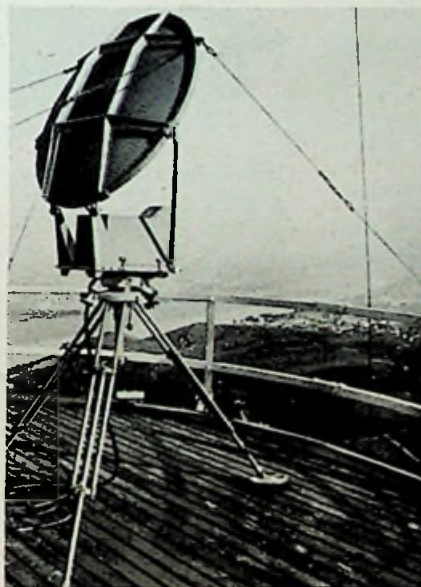
Oben und rechts: Bild 2. Fernsichtfunkstrecke auf der 70 m hohen Plattform des Antennennestes Kahlenberg bei Wien
